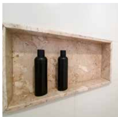
Nicho em mármore nos boxes dos sanitários;
